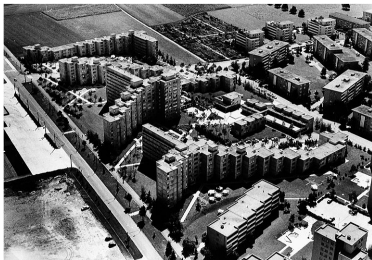
Die Staffelung der Gebäude sollte die Grüzefeld-Siedlung auflockern (Luftbild von 1970). Foto: winbib / Werner Friedli
