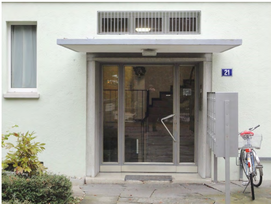
Wohnüberbauung «Brunnergut», bauzeitlicher Hauseingang (Vers. Nr. 05989), 21.11.2016 (Bild Nr. D101133_55).
