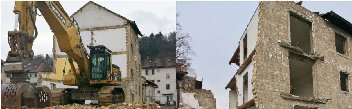
Abbruch der Siedlung Aeckerwiesen
